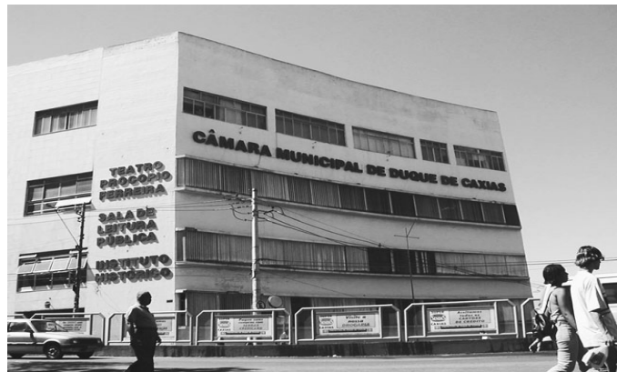
تصویر ۵-۸. ساختمان شهرداری کاسیاس، ۲۰۰۴، نرده‌ها و آسفالت به جای باغ جایگزین شده است. روی ساختمان نوشته شده است: "شهرداری دوکو د کاسیاس" و در دیوار کناری نوشته شده است: "تئاتر، اتاق مطالعه عمومی، بایگانی."
